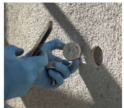
Haftzugprüfung der MC-RIM Mörtelbeschichtung
