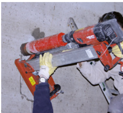
Bohrkernentnahme im Rahmen der Langzeit- untersuchung des MC-RIM Systems
